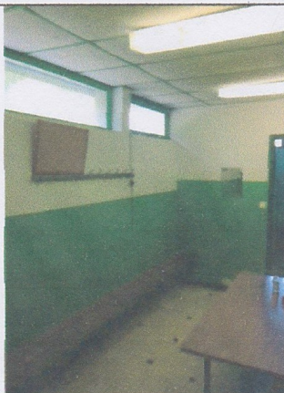
Photos vestiaire avant travaux
