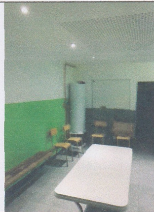
Photos vestiaire après travaux
