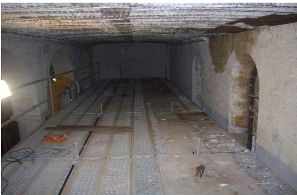
Un des collatéraux. Deux planchers, sur celui du bas, à gauche, un ouvrier travaille sur les murs. Le plancher du haut permet à autre ouvrier de travailler sur la voûte.
